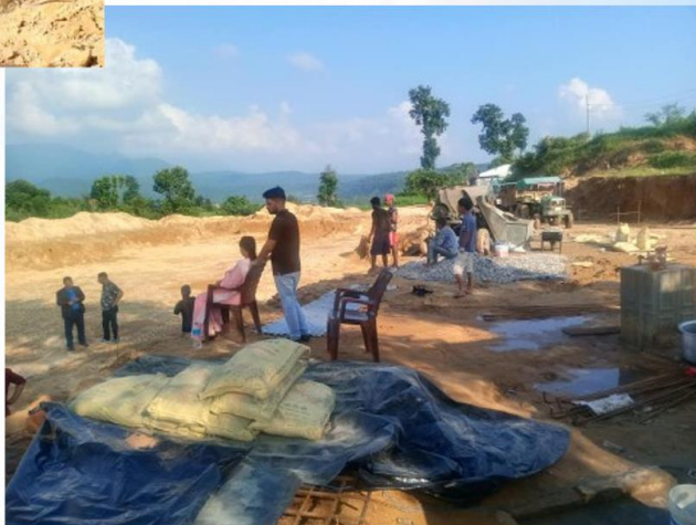
देवघाट आधारभुत अस्पताल निर्माण सुरुदेवघाट-५
