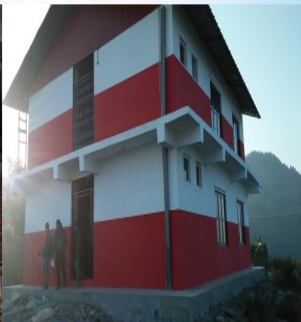
४ नं वडा कार्याल भवन, देवघाट-४
